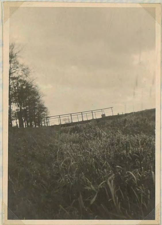
Zuleitungskanal vor der Herbsträumung
